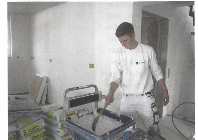
Hand in Hand: Azubi Daniel bedient im Erdgeschoss die Maschine, Roman trägt im Obergeschoss die Spachtelmasse auf.
